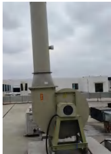
净化空调系统排气口（不涉及 污染物）
